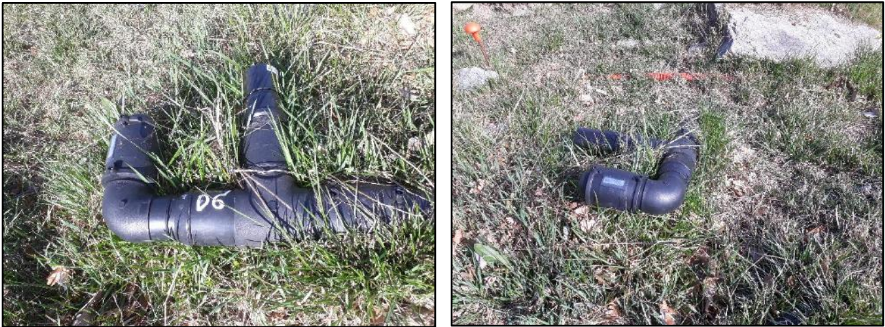
Fig 4: dreni D6 e D7 sigillati già dismessi in precedenza presenti sul Lotto 2.
