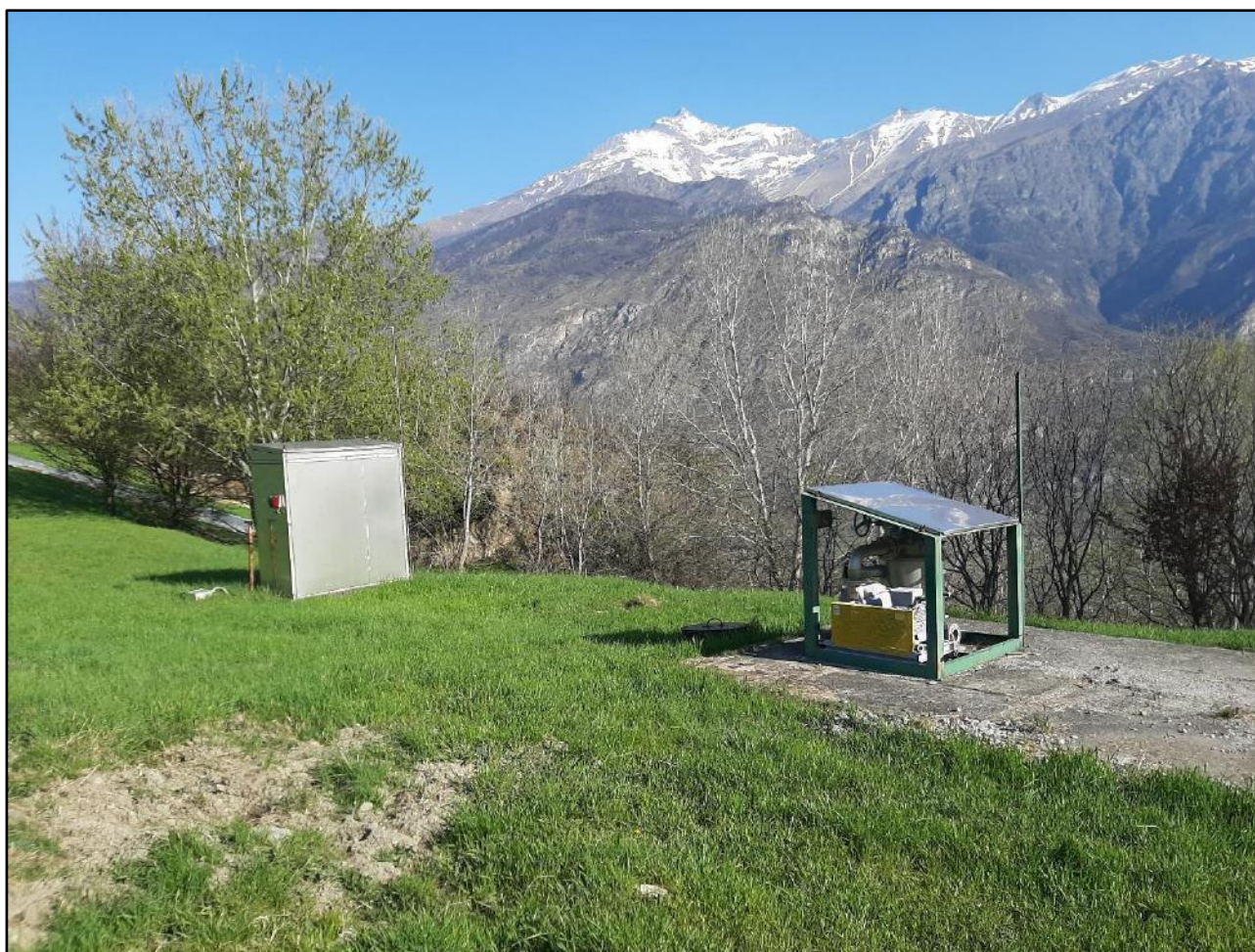
Fig 3: resti di apparecchiature vecchia centrale biogas dismessa sul lotto 1.
