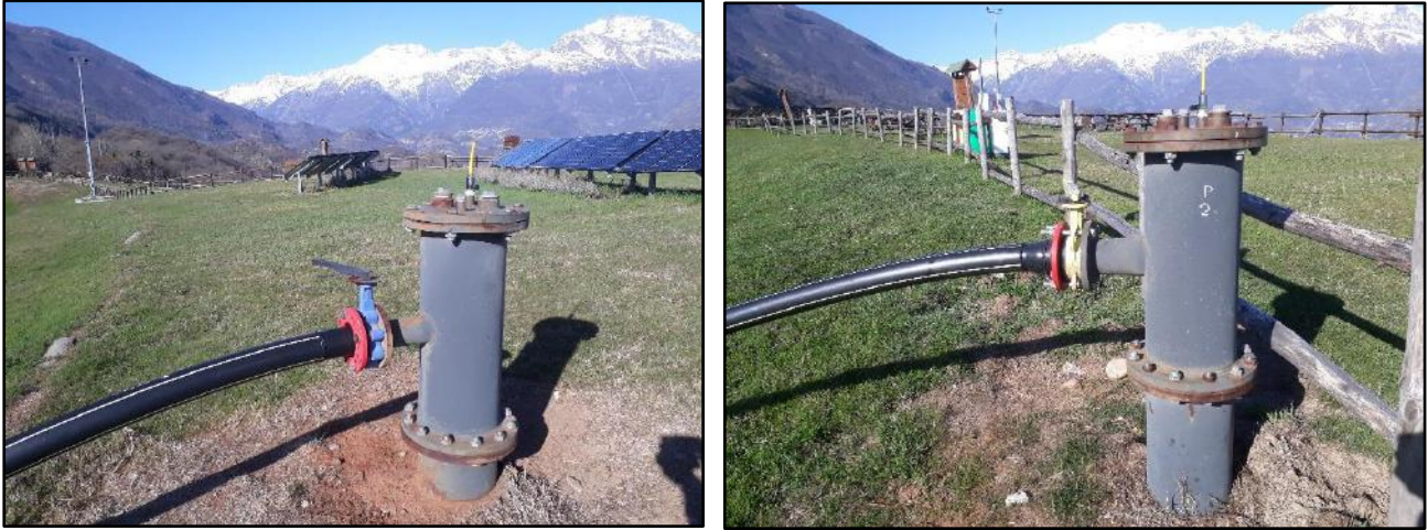
Fig 4: Pozzi P1 e P2 presenti sul Lotto 2 ripristinati e messi in depressione continua.
