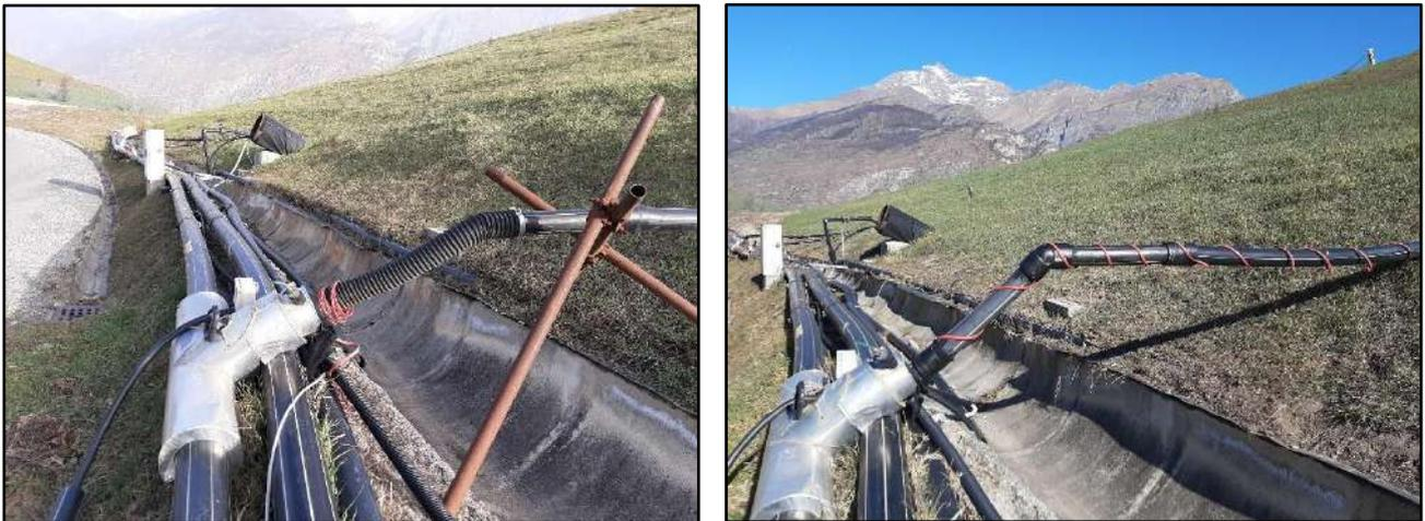
**Fig 9: nuovo collegamento rigido fra il pozzo B2 ed il collettore principale (prima e dopo).**
