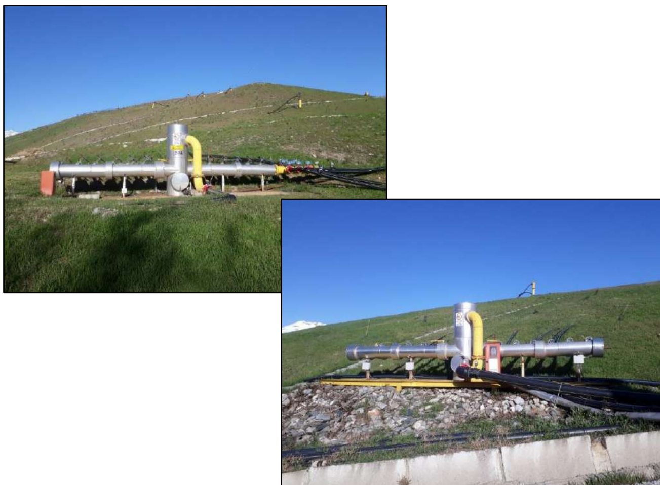
Fig 10: stazioni di regolazione SST 1 (sopra) es SST 2 (sotto)
