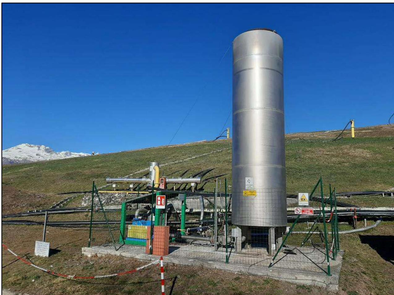
**Fig 1: Torcia di combustione biogas Lotto 2.**
