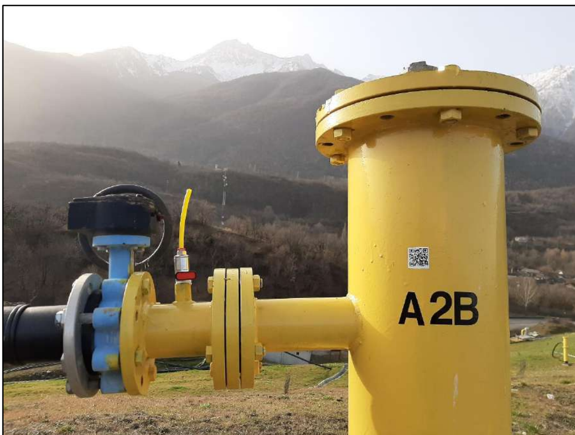
Fig 9: testa pozzo con valvola di campionamento rinnovata.
