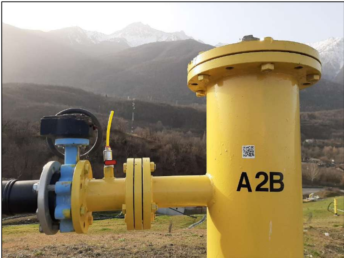
Fig 9: testa pozzo con valvola di campionamento rinnovata.
