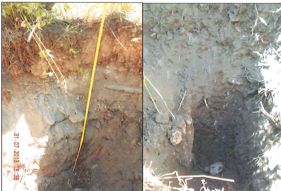
3-4. Realizzazione dei pozzetti di indagine: a sinistra punto di indagine n.1, a destra punto di indagine n.3.
