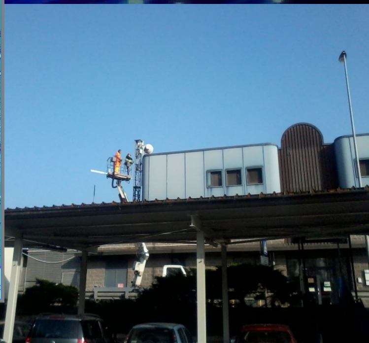
Lavori di allacciamento al nodo di Avigliana
